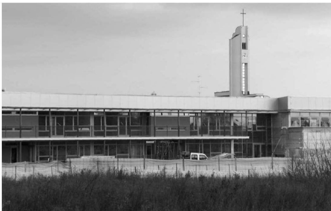
Slika 32 Izgradnja dječjeg vrtića na Zelenom Brijegu
