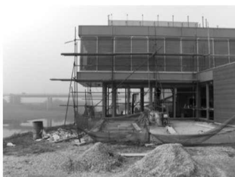
Slika 46 Vidikovac na obali rijeke Kupe u izgradnji
