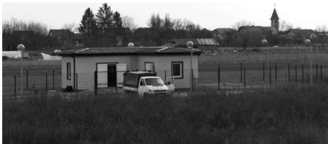
Slika 26 Vakuum stanica kanalizacije u Galdovu
