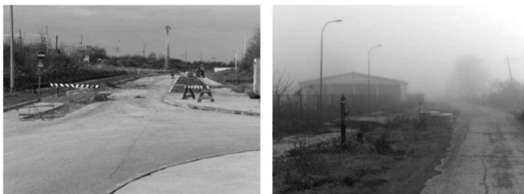
Slika 21 Gradnja infrastrukture u poslovnim zonama
