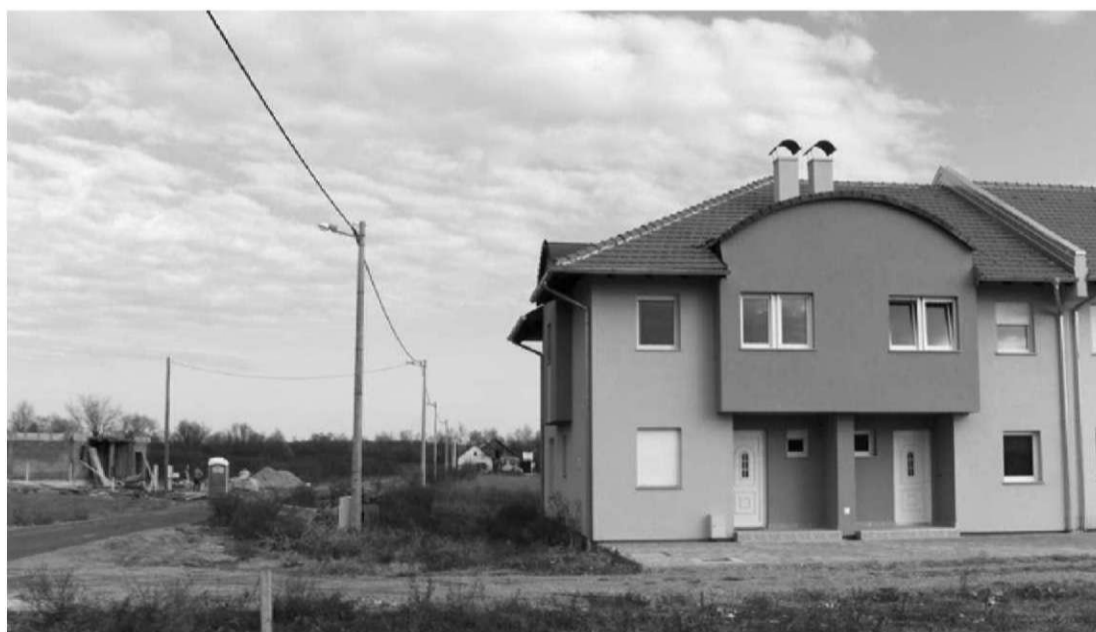
Slika 25 Izgradnja javne rasvjete u novim stambenim naseljima
