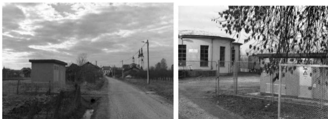
Slika 31 Lokalne trafostanice TS 10(20)/0,4 kV
