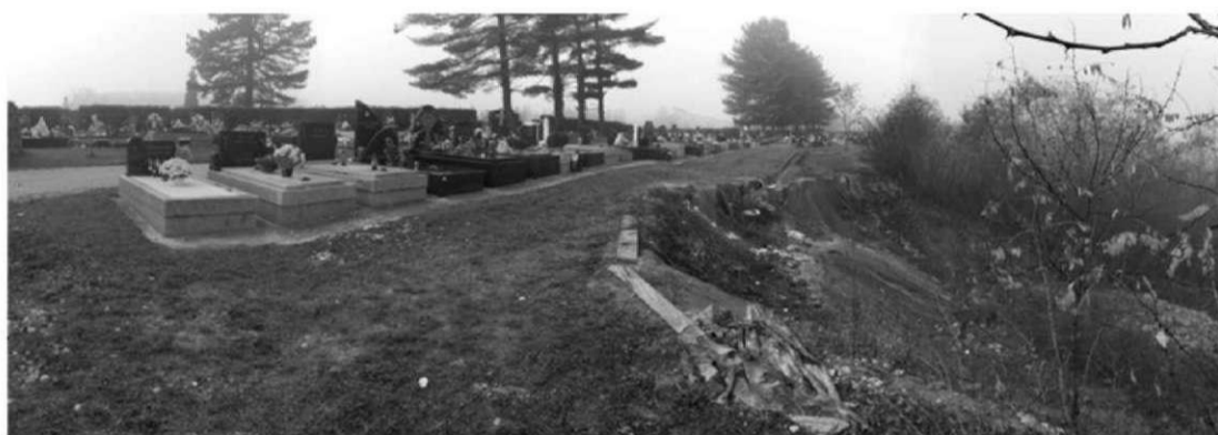
Slika 24 Sanacija klizišta na groblju Vitorovac u Sisku
