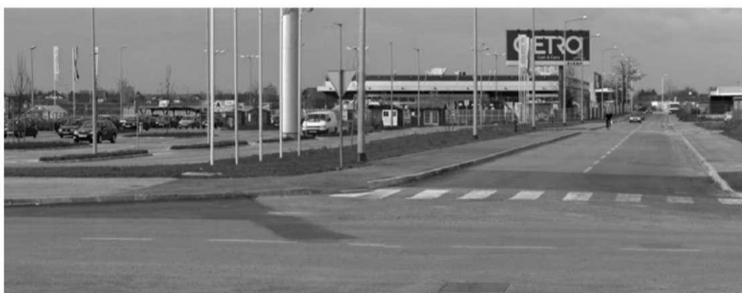
Slika 20 Izgradnja infrastrukture u Komunalnoj zoni
