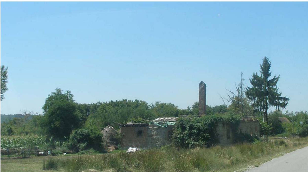
RUŠEVINE ZGRADE STARE ŠKOLE U DUMAČAMA
