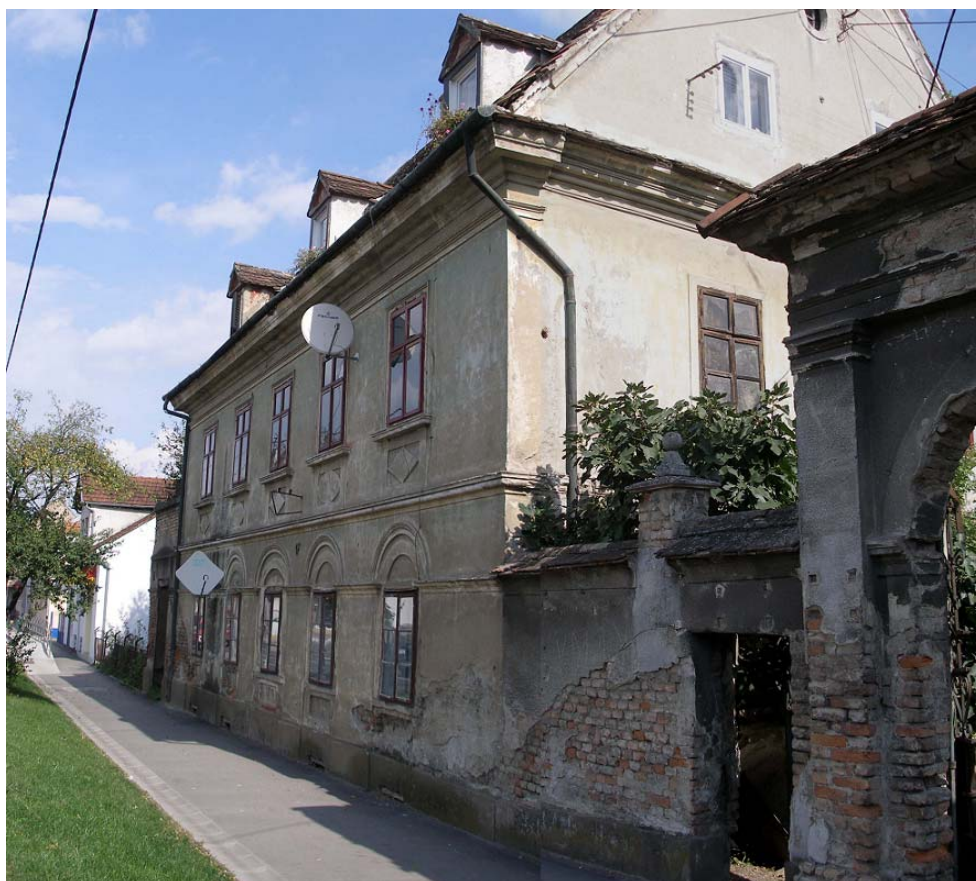
ULICA J.J. STROSSMAYERA 23, VRANJICANIJEVA KUĆA
