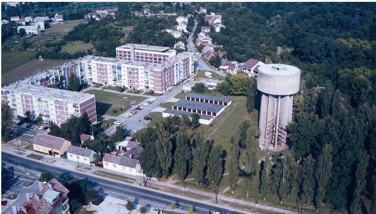
VIŠESTAMBENA IZGRADNJA U STROSSMAYEROVOJ ULICI UZ VODOTORANJ
