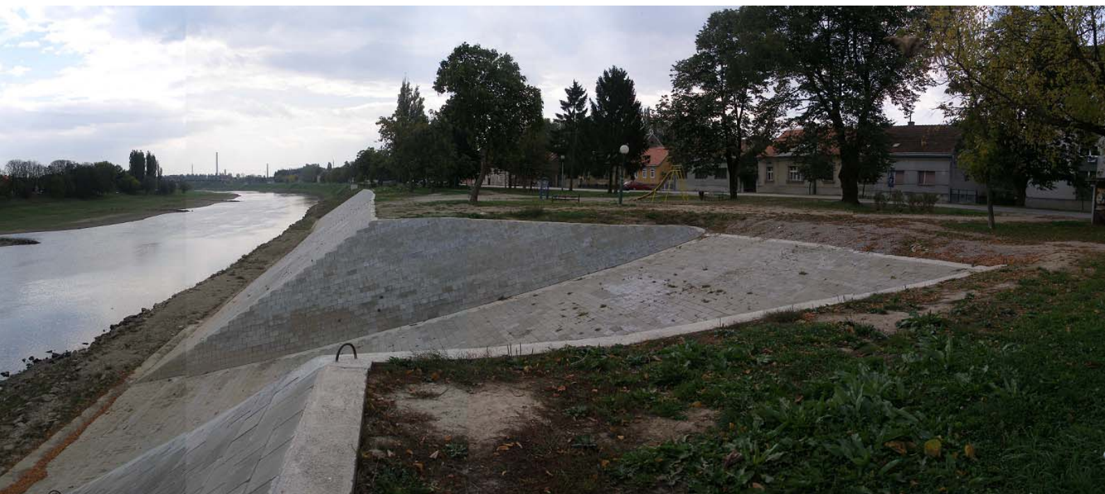
SANIRANI DIO OBALOUTVRDE NA DESNOJ OBALI RIJEKE KUPE
