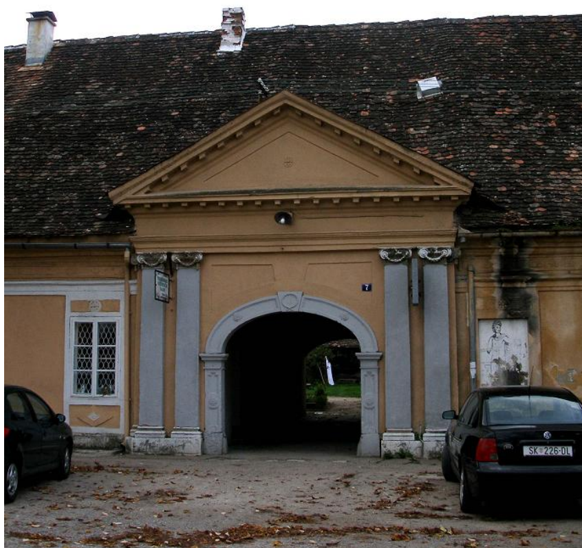
LAĐARSKA OBALA 5 – 9, KUĆA GLIEDERER – PETRIĆ, PORTAL
