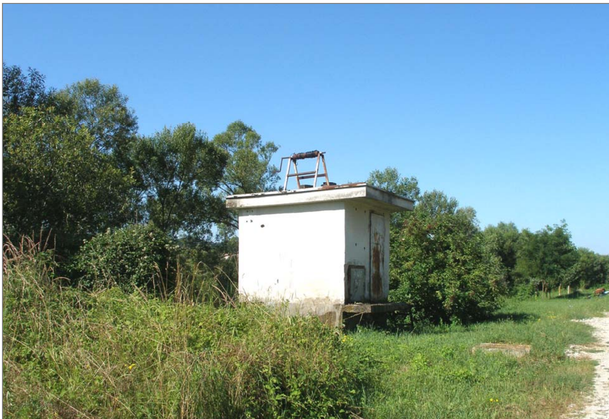
POSTOJEĆI ISPUST OTPADNIH VODA U UNSKOJ ULICI
