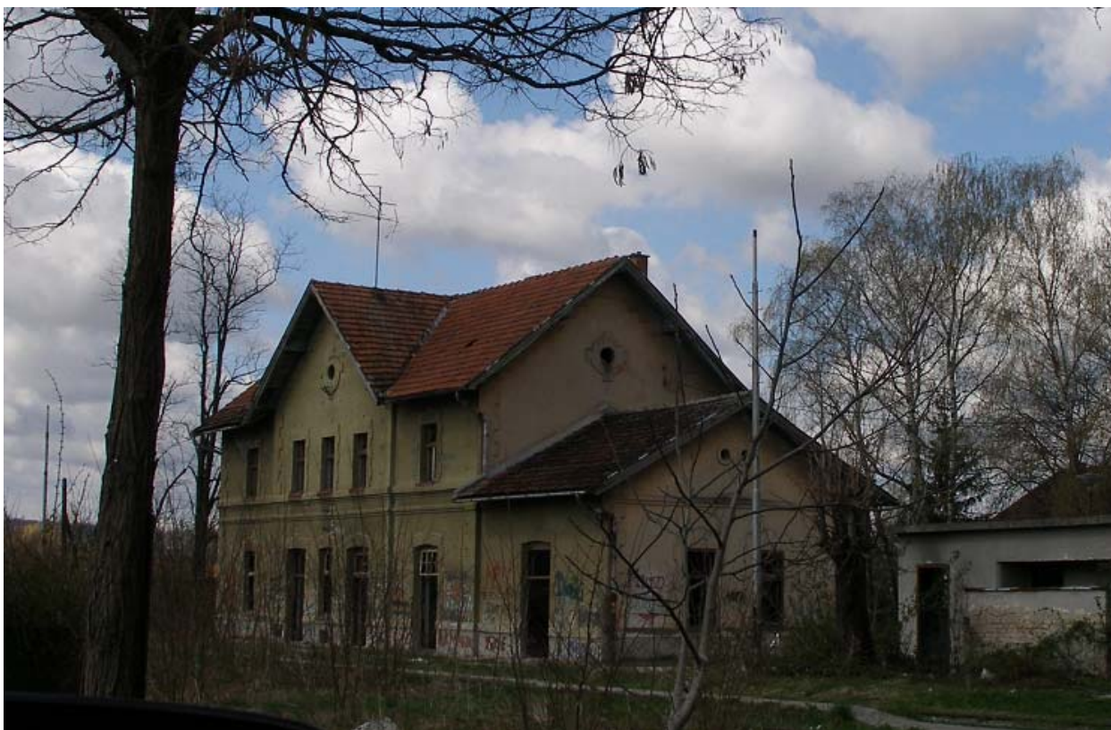
današnje stanje željezničkog kolodvora u Petrinji
