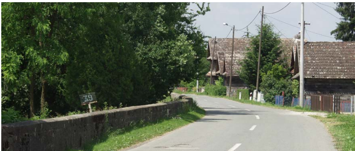
Slika 54. Obrambeni zid od velikih voda u Drenovom Boku
