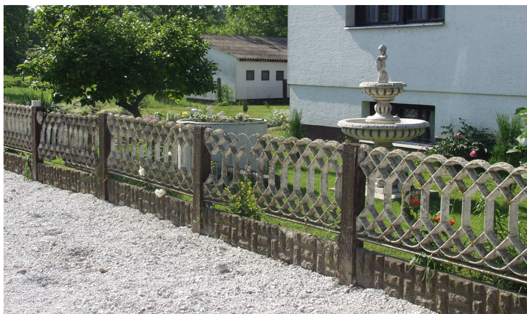
Sl. 33. Neprimjereno korištenje betonskih prefabriciranih elemenata
