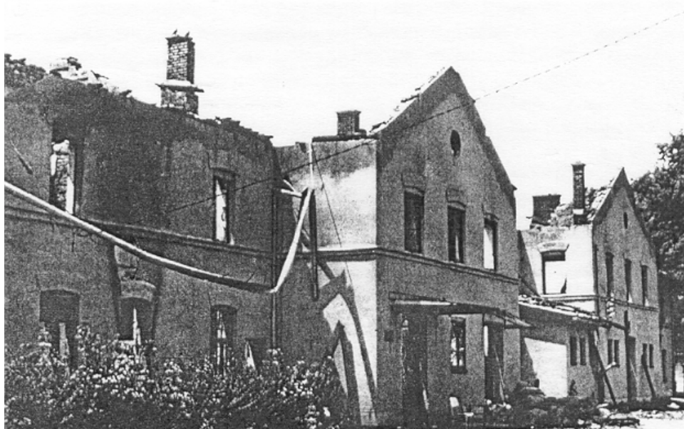
Sunja - uništena zgrada željezničkog kolodvora
