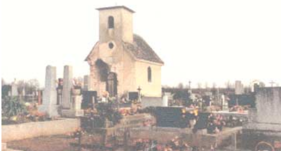
Porušena kapela na groblju u Sunji
