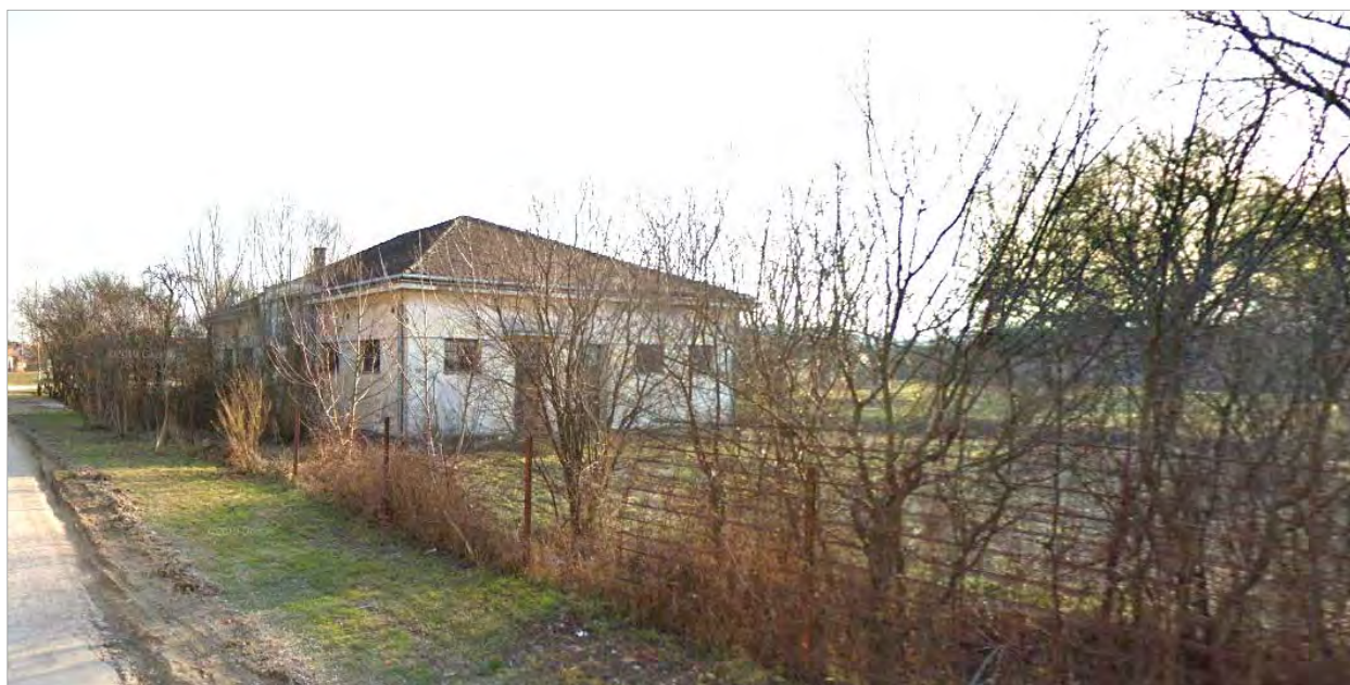
POSTOJEĆA POSLOVNA ZGRADA PLANIRANA ZA PRENAMJENU U DJEČJI KULTURNI CENTAR
