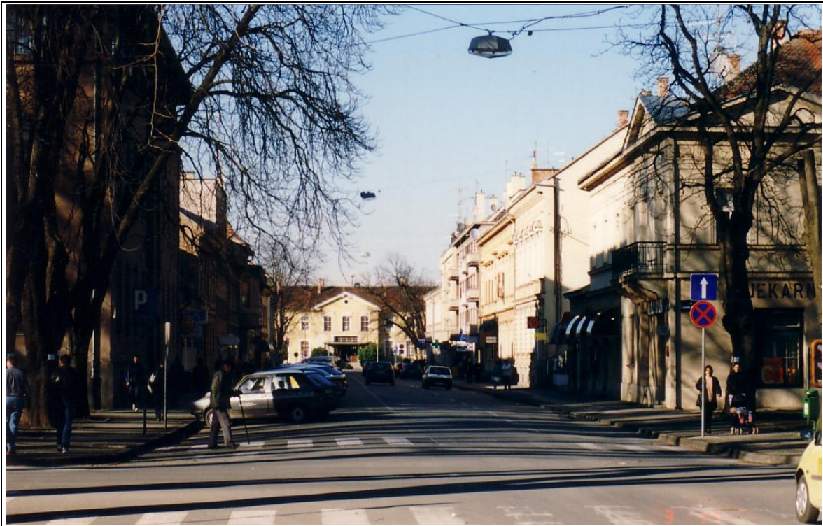
dio centra sa sačuvanom Fistrovićevom urbanom strukturom ( ulica S. i A. Radića sjeverno od trga Lj. Posavskog)
