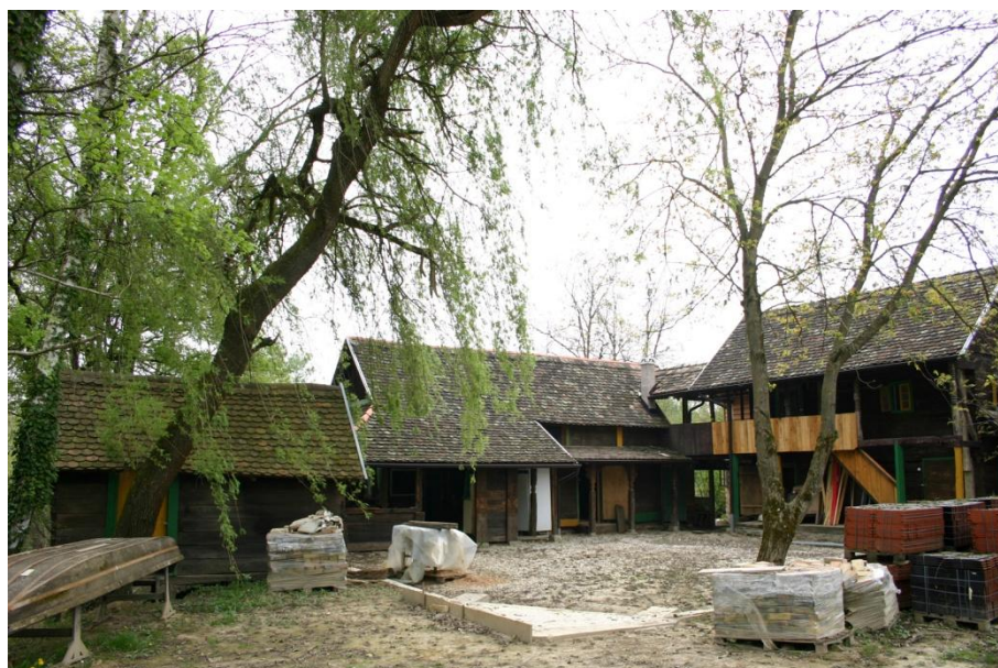
Slika 2. Izgradnja etno gospodarstva
