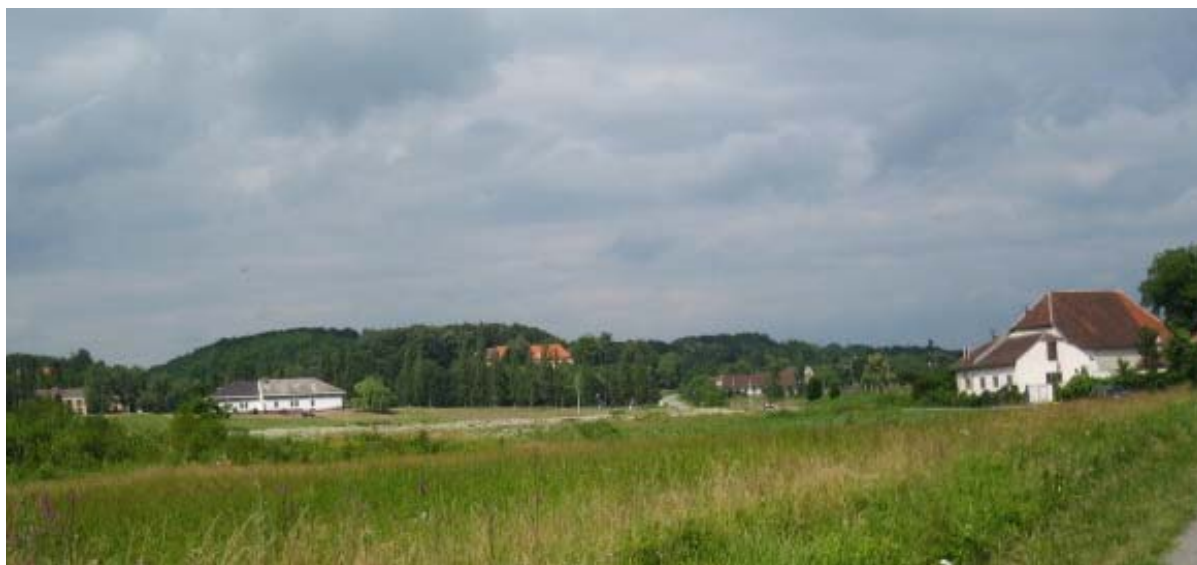
slika 1 – Smještaj povijesnoga sklopa dvorca Erdödy, pogled s juga iz doline potoka Jelenska, 2006.
