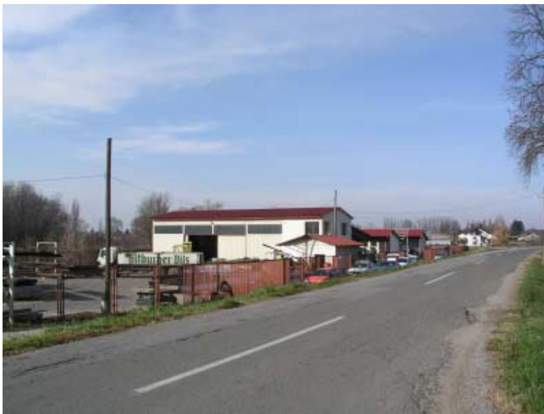
Gospodarske građevine u Topolovcu izgrađene izvan građevinskog područja naselja
