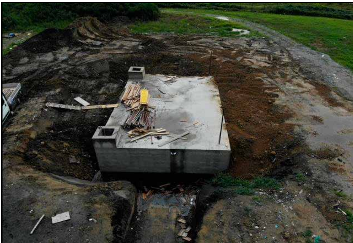
Slika 8. : Pogled na izvedeni AB sabirni bazen
