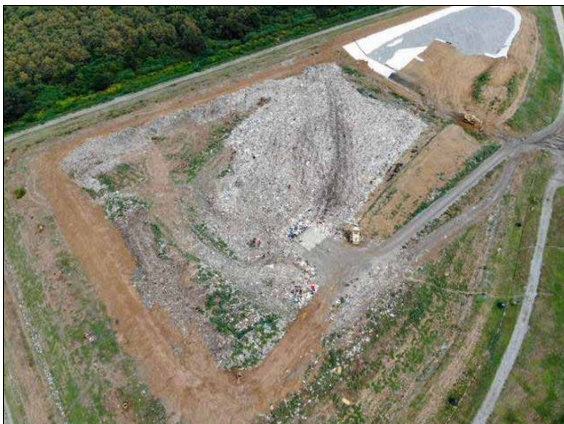
Slika 9.: Pogled na izradu obodnog nasipa na aktivnom dijelu odlagališta
