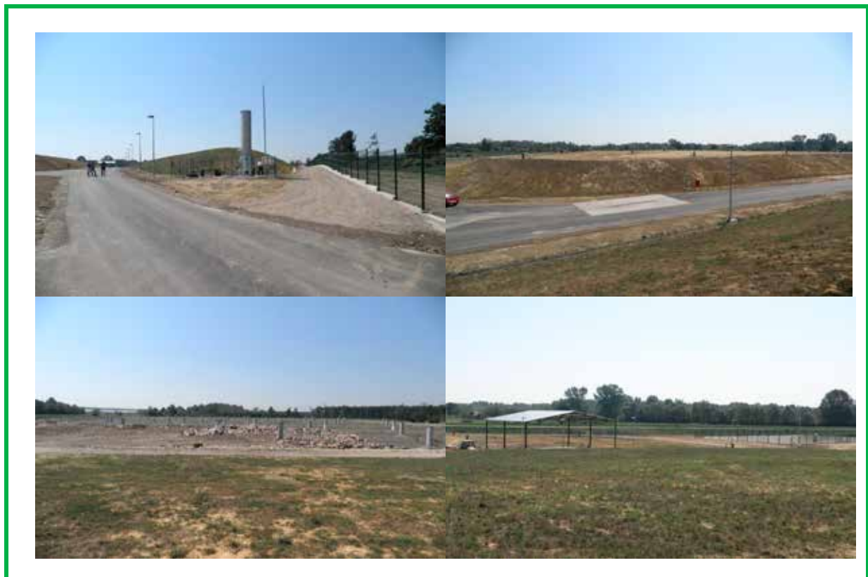
Slika 5.: Stanje nakon sanacije
