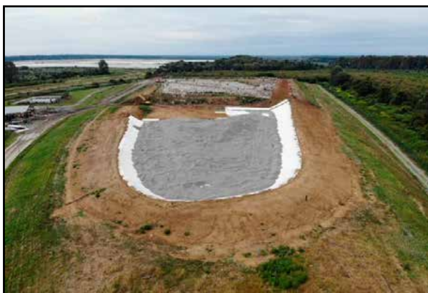
Slika 7.: Pogled na radove ugradnje drenažnog sloja šljunka
