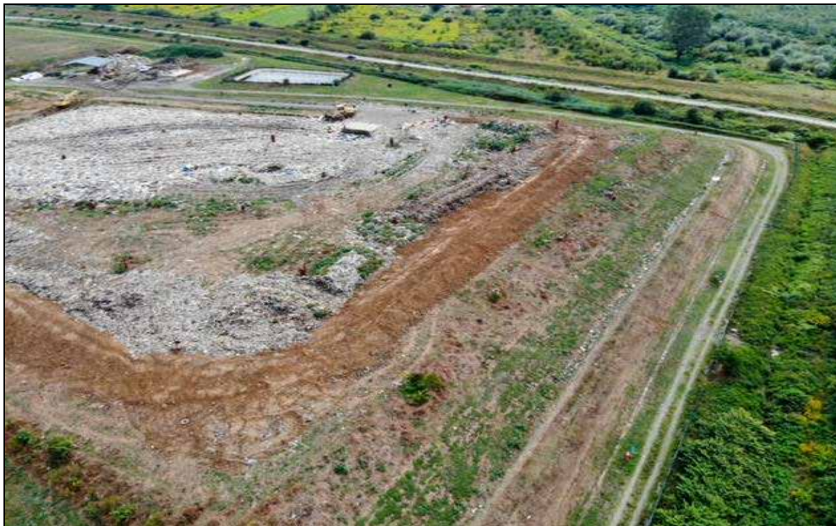
Slika 10.: Pogled na izradu obodnog nasipa na aktivnom dijelu odlagališta
