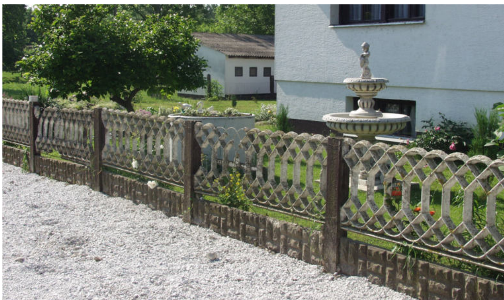
Sl. 33. Neprimjereno korištenje betonskih prefabriciranih elemenata
