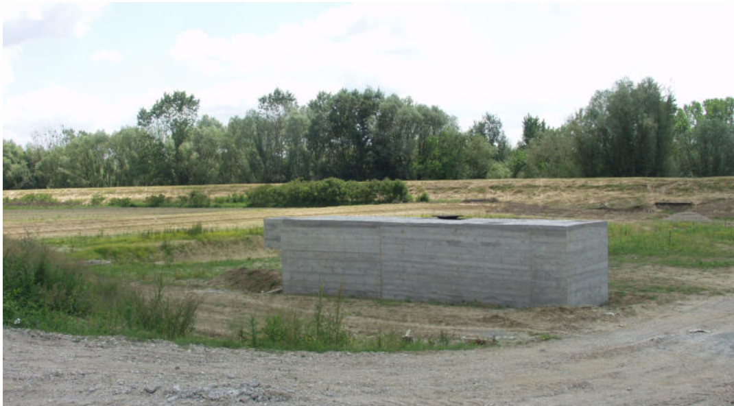
Sl. 44. Uređaj za obradu otpadnih voda u izgradnji – naselje Jasenovac
