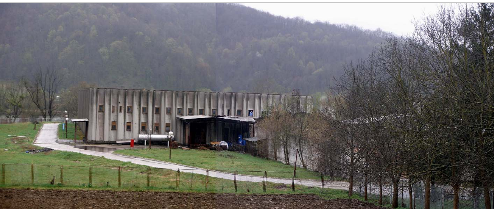
POGON TVORNICE "POUNJE" d.d. U HRVATSKOJ KOSTAJNICI
