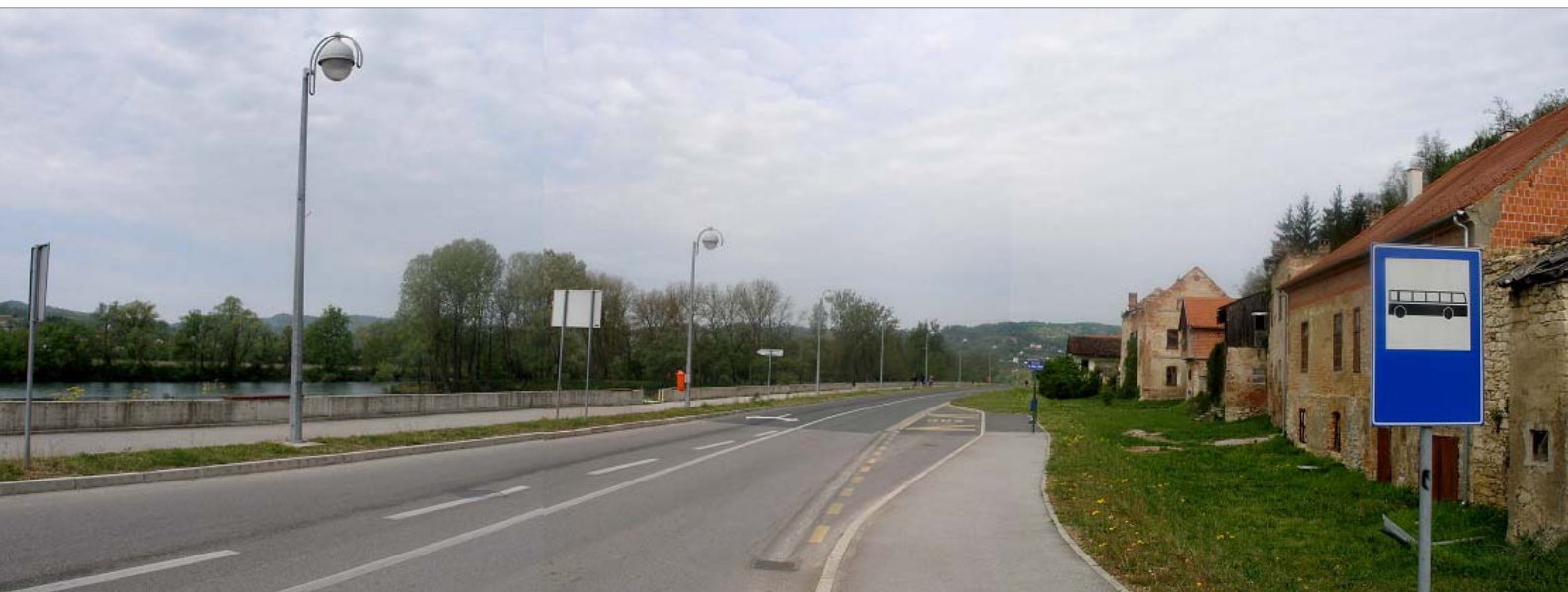
ŠETALIŠTE DR. FRANJE TUĐMANA NA OBALOUTVRDI RIJEKE UNE NA KOJU JE PREUSMJEREN PROMET IZ ULICE DAVORINA TRSTENJAKA NA PRAVCU D47
