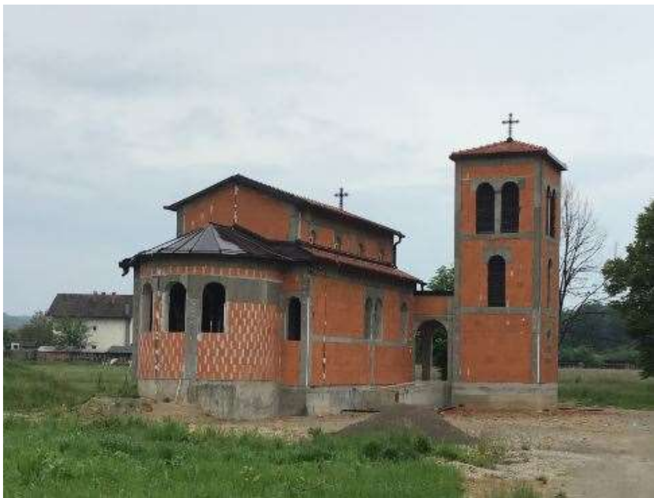
Slika 8: Pravoslavna crkva u Vrginmostu u izgradnji
