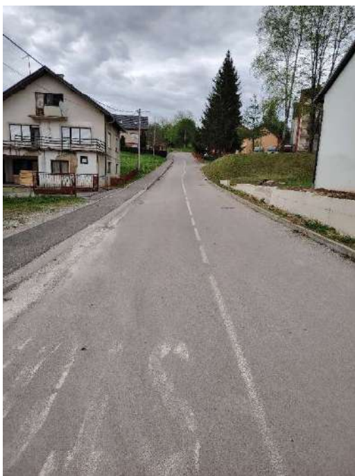
Slika 50. Izgrađena prometnica Novo naselje Izvor: ZPUSMŽ
