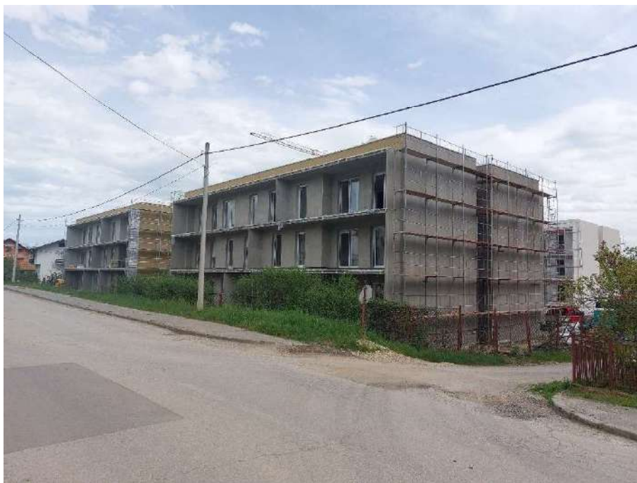
Slika 44. Započeta izgradnja višestambenih zgrada u okviru OPKK projekta Izvor: ZPUSMŽ
